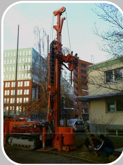
Germany (Deutschland) Augering, with Casing Rotary Table (Trockenbohren mit Schnecke, mit Drehtisch)
