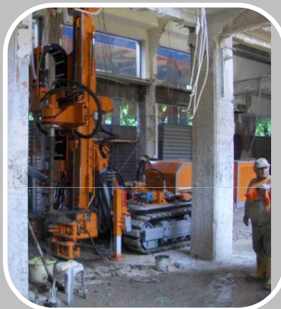
Greece (Griechenland) Micro Pile, Augering (Mikropfahl, Trockenbohren mit Schnecke)
