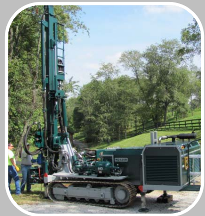
USA DTH Hammer Drilling (Im-Loch-Hammerbohren)
