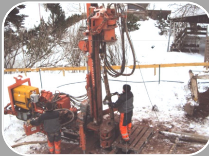
Germany (Deutschland) - DTH hammer drilling (Im-Loch-Hammerbohren)
