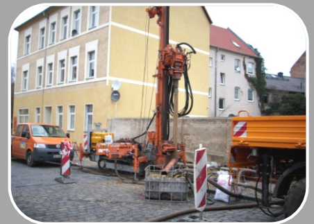
Germany (Deutschland) - Rotary Mud Drilling (Spülbohren)
