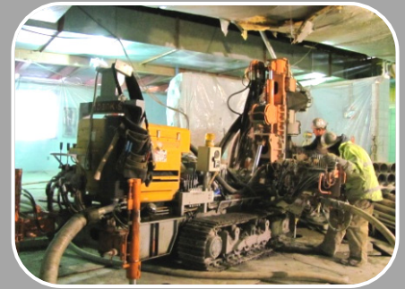
USA - Drilling in low head room (Bohren unter niedriger Decke)
