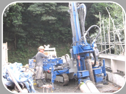
Hong Kong - Micro Piling (Mikropfahl)
