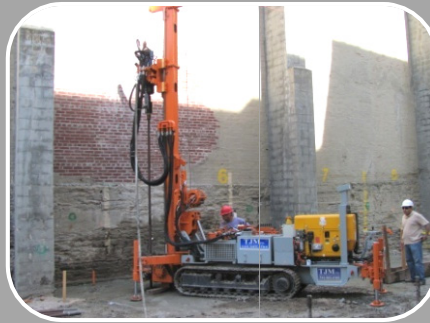
USA - Drifter Drilling (Bohren mit Hydraulikhammer)
